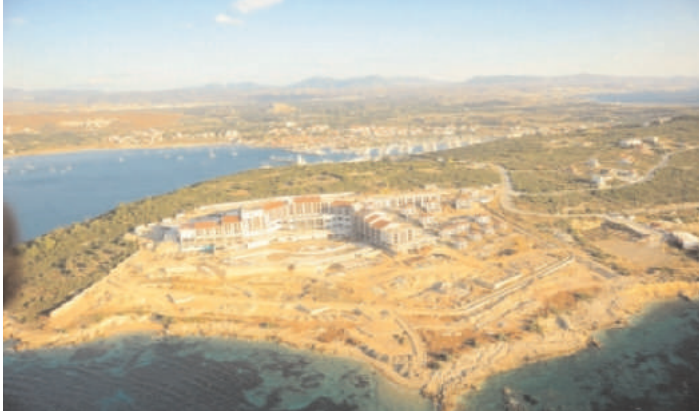
Resim 2. Seferihisar’da bir otel inşa alanının görünümü
