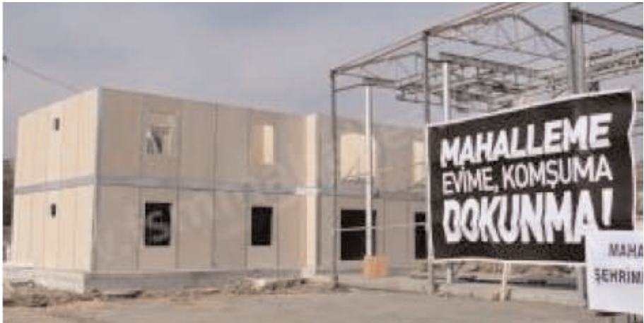
Fotoğraf 2. Rezerv Alan’da yapımına başlanan prefabrik konteyner inşaatı
